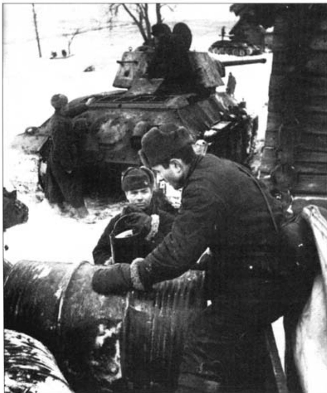
Экипаж Т-34/76Д заправляет танк горючим, зима 1942 г. Танк оснащен двумя башенными люками. Кроме того, на башне появились поручни для десанта. Шестиугольная башня не имела выступа сзади. Танки ранних версий имели башни с такими выступами, чем пользовались немецкие пехотинцы — они подкладывали под них плоские противотанковые мины.
