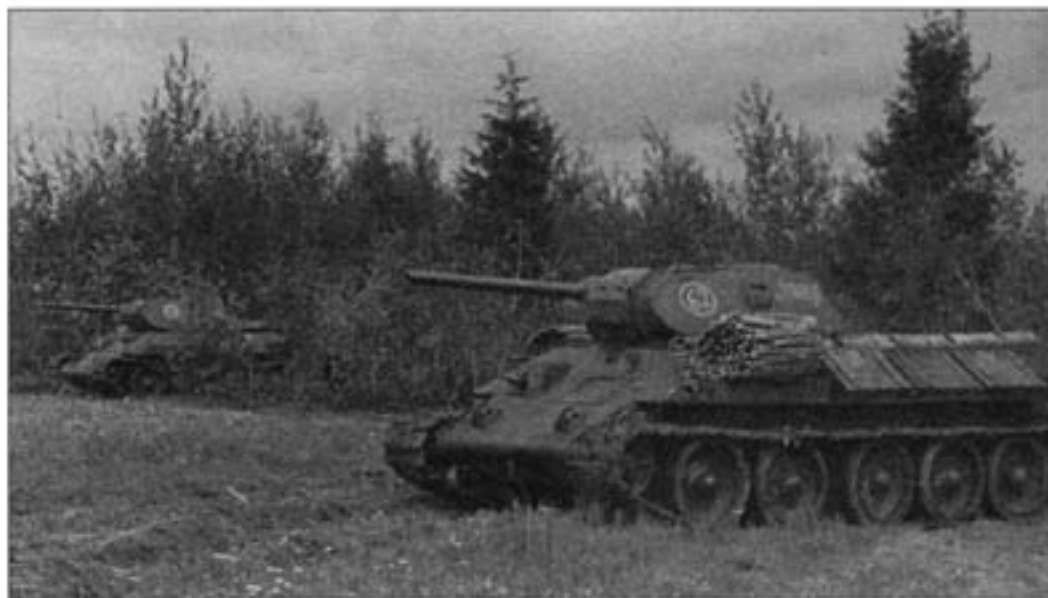
Танки Т-34/76 выезжают из лесополосы. Первое появление этих быстрых, хорошо вооруженных и имеющих мощную броню танков вызвало у немецких солдат панику – они обнаружили, что их 37-мм противотанковые пушки Pak 35/36 не пробивают броню советских танков. Для борьбы с Т-34 стали использовать 88-мм зенитки – их снаряды и обладающие крепкими нервами расчеты могли остановить прорыв советских танков.
