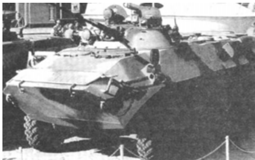
На опытный БТР-90 устанавливались стандартная башня с БМП-2.
