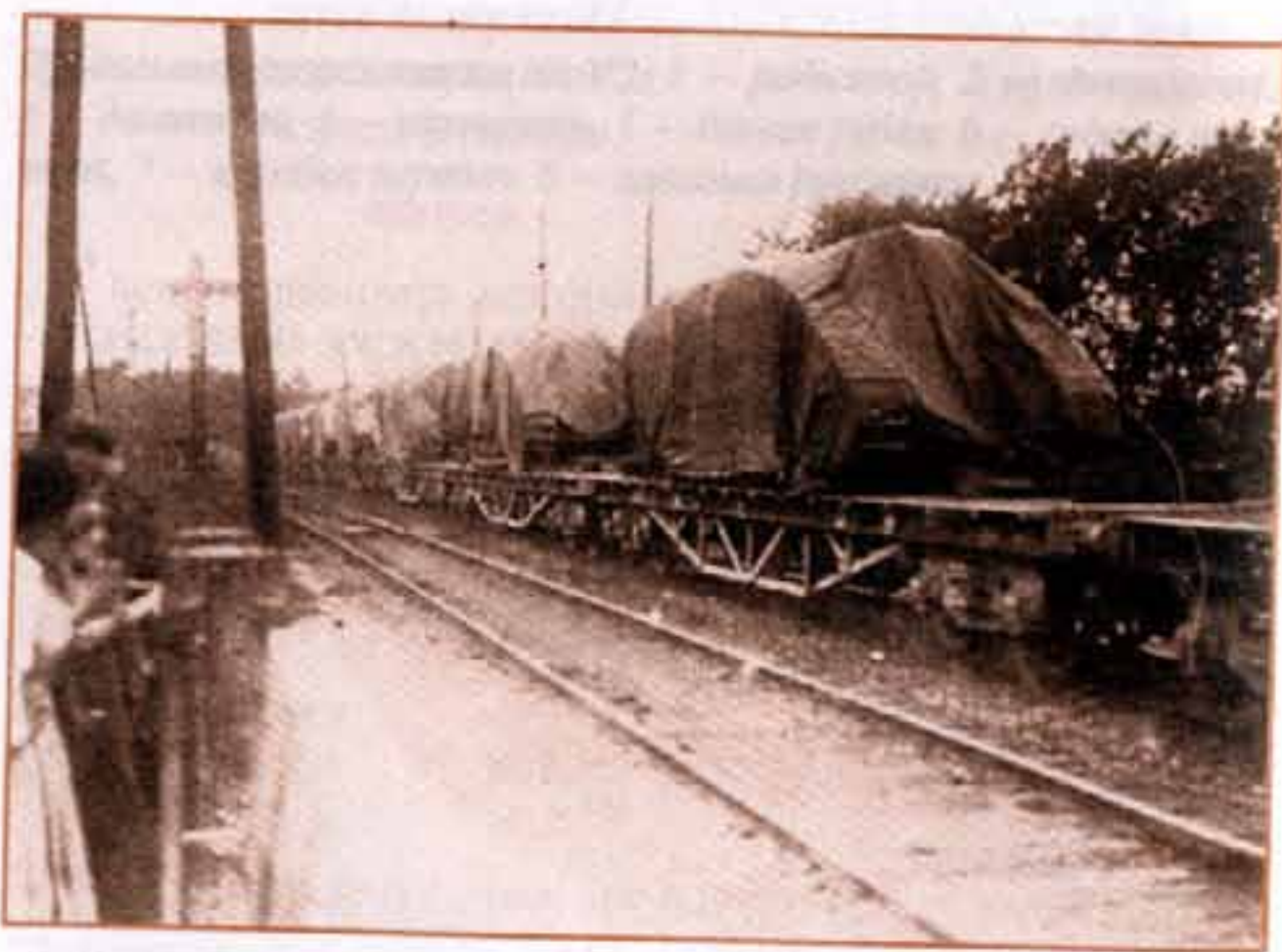
Переброска танков Mk V по железной дороге. Видно, что спонсоны убраны внутрь корпуса.
