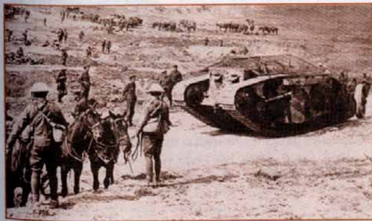
Танк Mk I «самец» с «обезьянней клеткой» на крыше. 15 сентября 1916 г., близ Флер.
