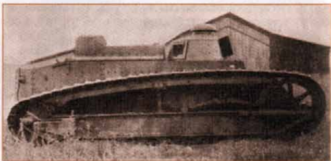
Французский опытный средний танк «Делоне-Бельвиль» — этот проект «вырос» из попытки создания собственного легкого танка.
