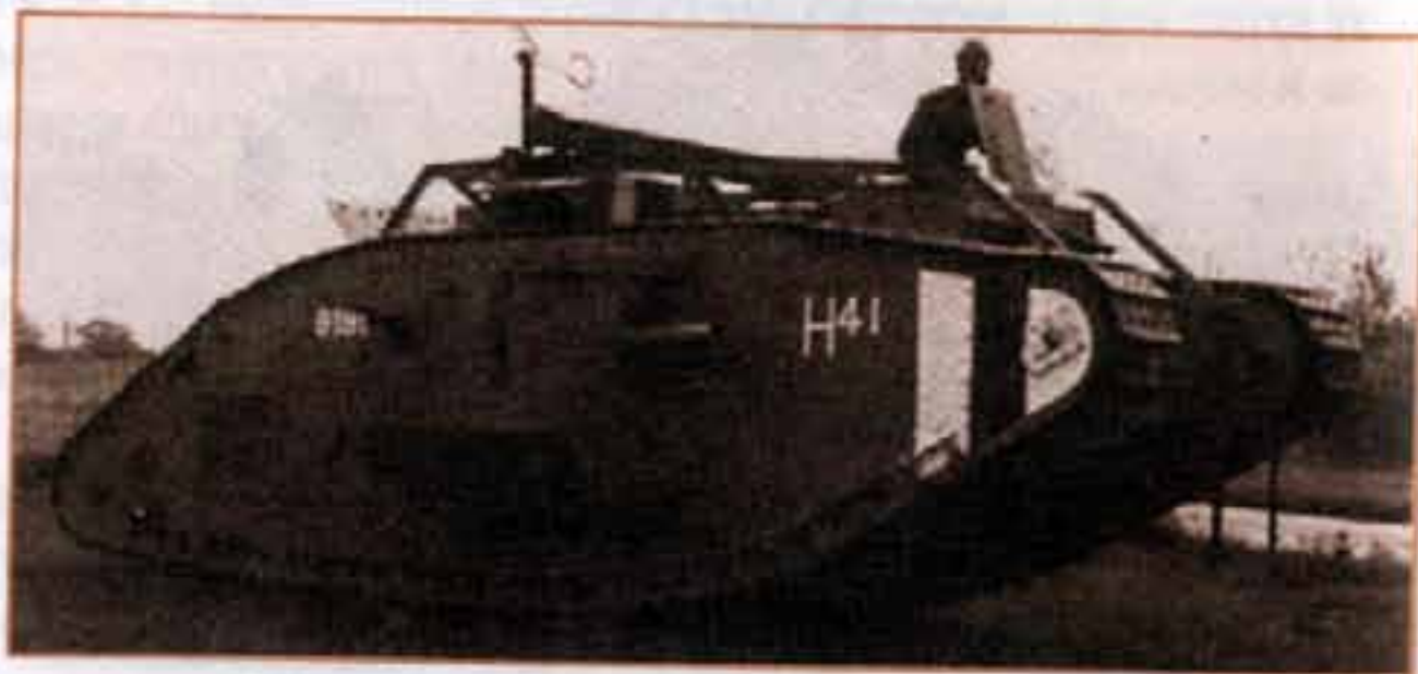
Мк V «самец» с сигнальным семафором позади кормовой рубки.
