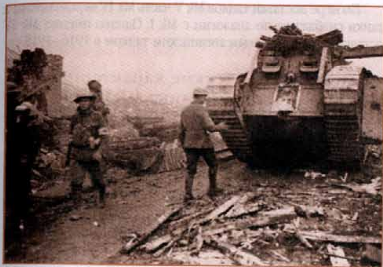
Танк снабжения на основе Mk IV.
