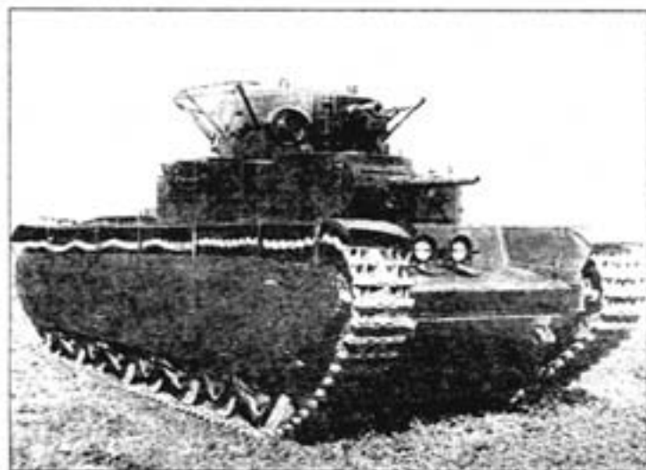
Общий вид танка Т-35. Кубинка, 1947 год. Хорошо видна установка фор в броневых кожухах. В настоящее время эта машина находится на экспозиции Военно-исторического музея бронетанкового вооружения и техники.
