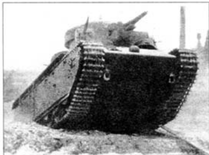
Т-35-1 преодолевает вертикальную стенку высотой 1 метр. Август 1932 года.
