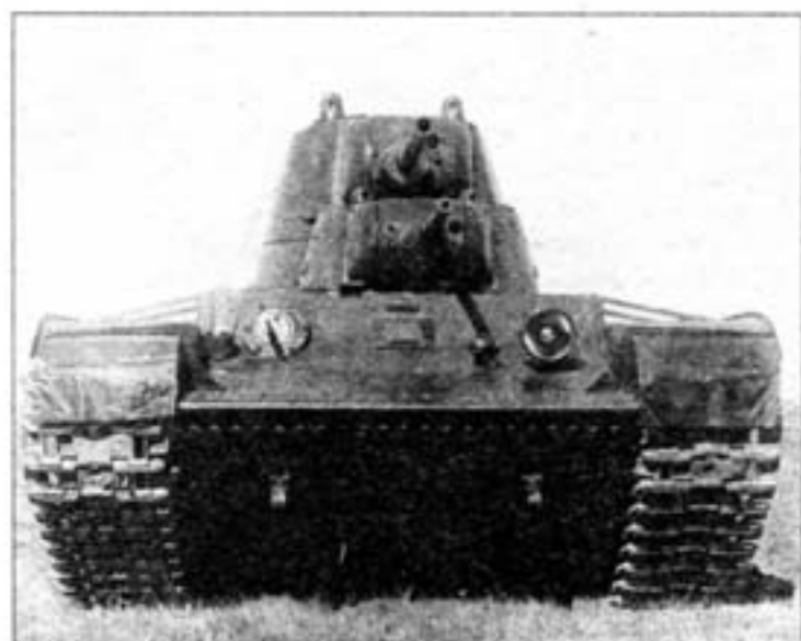
Танк СМК на полигонных испытаниях. Август 1939 года. Хорошо видна форма траков, установка курсового пулемета, фара и звуковой сигнал.
