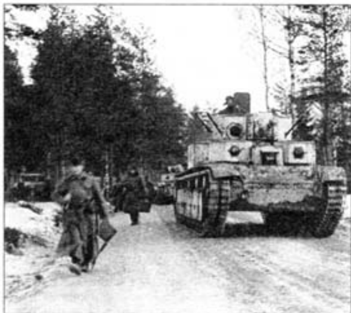
Танк Т-28 на марше. Северо-Западный фронт, январь 1940 года. Это машина выпуска 1938 года с пушкой Л-10 и поручневой антенной.
