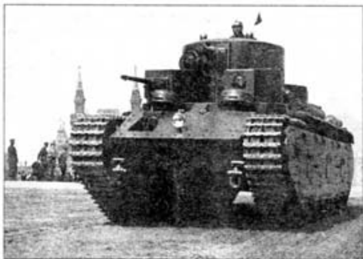
Танк Т-35-2 на параде 7 ноября 1933 года в Москве. Колпаки водителя и стрелка в открытом положении, на левом борту видна укладка брезента.
