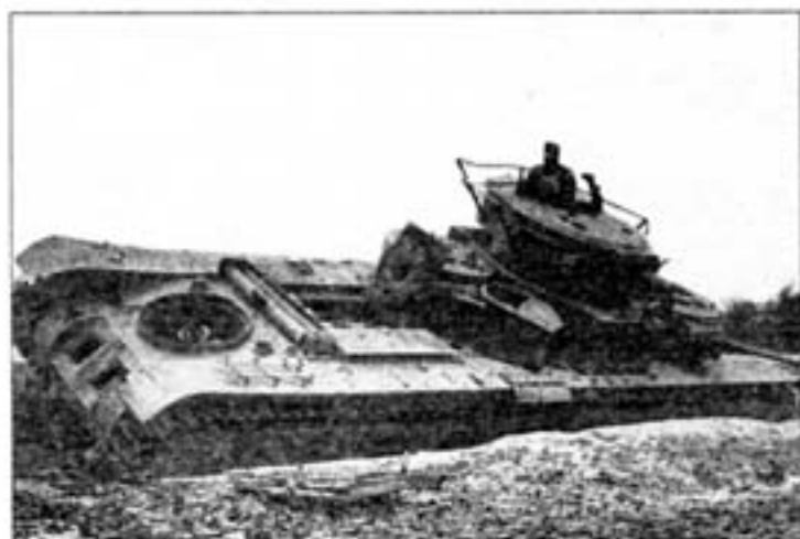
Брошенный экипажем Т-35. Фото сделано осенью 1941 года. Машина выпуска 1936 года: с ранним типом гусениц и двумя люками в главной башне.
