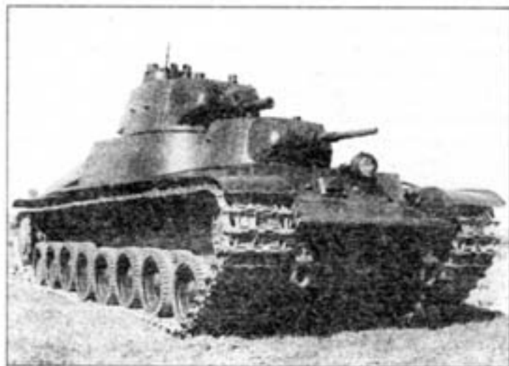
Танк Т-100 на полигонных испытаниях. Август 1939 года. Хорошо видна зенитная пушечная установка на крыше большой башни.
