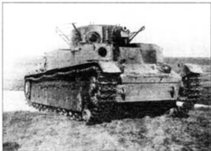
Общие виды танка Т-28 выпуска 1936 года. Машина имеет колпак над вентилятором с жалюзи и односторонним локом, шаровую установку в нише башни, два лока в крыше башни и измененную (по сравнению с танками предыдущих серий) укладку ЗИП.
