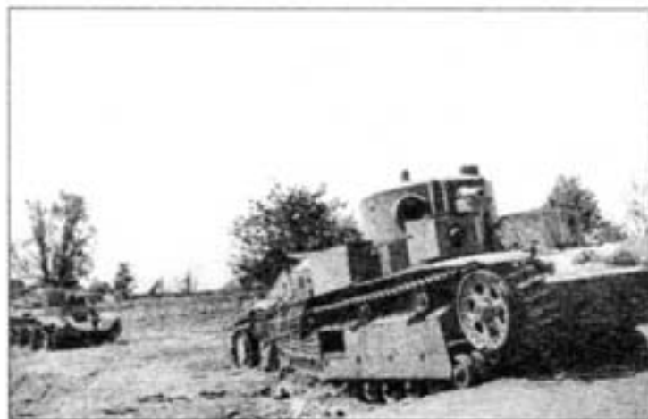
Танки Т-28 и БТ-7 5-й танковой дивизии, брошенные экипажами. Район Алитуса, 24 июня 1941 года. Судя по всему, у Т-28 перебито правую гусеницу. Скорее всего, эта машина выпуска 1938 года с решеткой для укладки брезента на правом борту.
