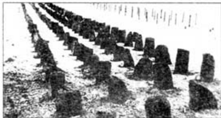
Противотанковые препятствия на «линии Маннергейма» — гранитные надолбы в 4 ряда. Декабрь 1939 года.
