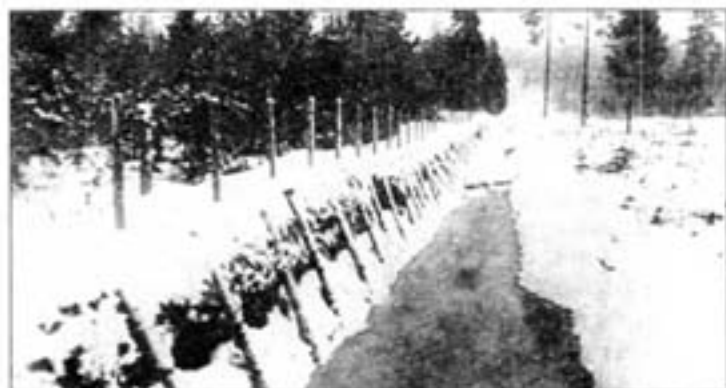
Противотанковые препятствия на «линии Маннергейма» — противотанковый эскарп, вклинены гранитные надолбы в 4 ряда. Декабрь 1939 года.
