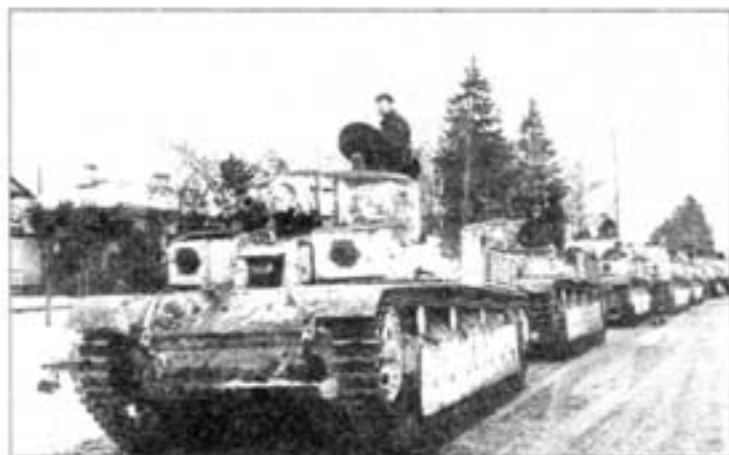
Танки Т-28 20-й тяжелой танковой бригады на марше. Февраль 1940 года. Первые две машины выпуска первой половины 1939 года.
