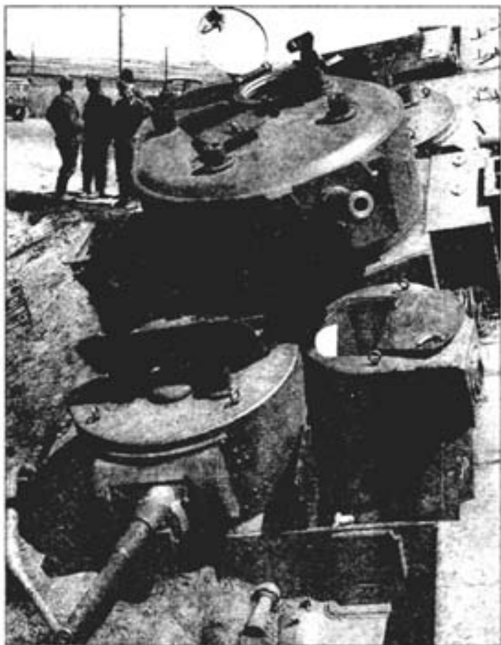
Танк Т-35 выпуска 1938 года, брошенный экипажем из-за поломки. Июнь 1941 года. Пулеметные башни имеют дополнительную бронезащиту шаровой установкой.
