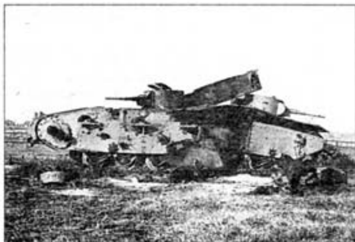
Один из немногих Т-35, подбитый в бою. Район Дубно, июль 1941 года. В бортовом экране видны несколько снарядных пробоин, что, по-видимому, вызвало взрыв горючего и боекомплекта.
