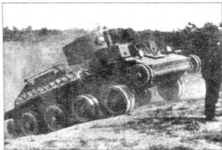
Колесо-гусеничный танк Т-29-4 преодолевает подъем на колесном ходу. Лето 1935 года. На борту видна укладка гусениц и поручневая антенна.
