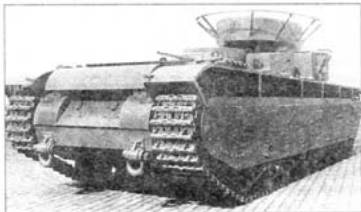
Танк Т-35А выпуска 1936 года во дворе ХТЗ, вид слева и сзади. Глушитель расположен поперек корпуса, у кормы надгусеничных полоз видны выводные патрубки приборов дымопуска.
