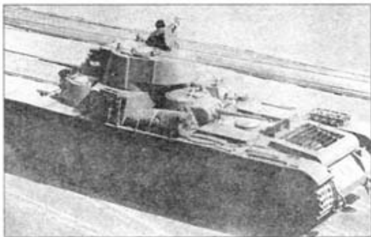
Танк Т-35 с коническими башнями и наклонной подбашенной коробкой. Москва, 1 мая 1940 года. На фото хорошо видно отсутствие пулеметной установки в нише главной башни, укладка ЗиП и конструкции люков для доступа к трансмиссии.
