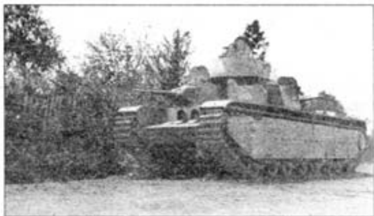
Брошенный Т-35 с коническими башнями. Июль 1941 года. Танк выпуска 1939 года с наклонной подбашенной коробкой.
