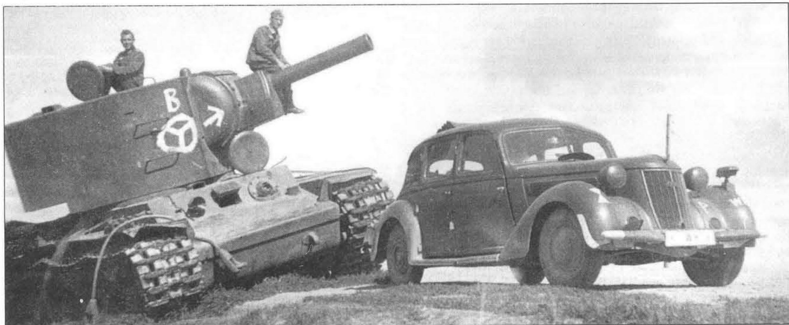
«Техническая остановка» у брошенного танка КВ-2. Обратите внимание на имевшие место, и очевидно кончившиеся неудачей попытки восстановить машину, немецкую литеру «В» - маркировку для трофейной техники, а также на указатель расположения 12-й танковой дивизии. Рядом с танком на переднем плане стоит легковой автомобиль Wanderer W23, принадлежащий 183-й пехотной дивизии.
