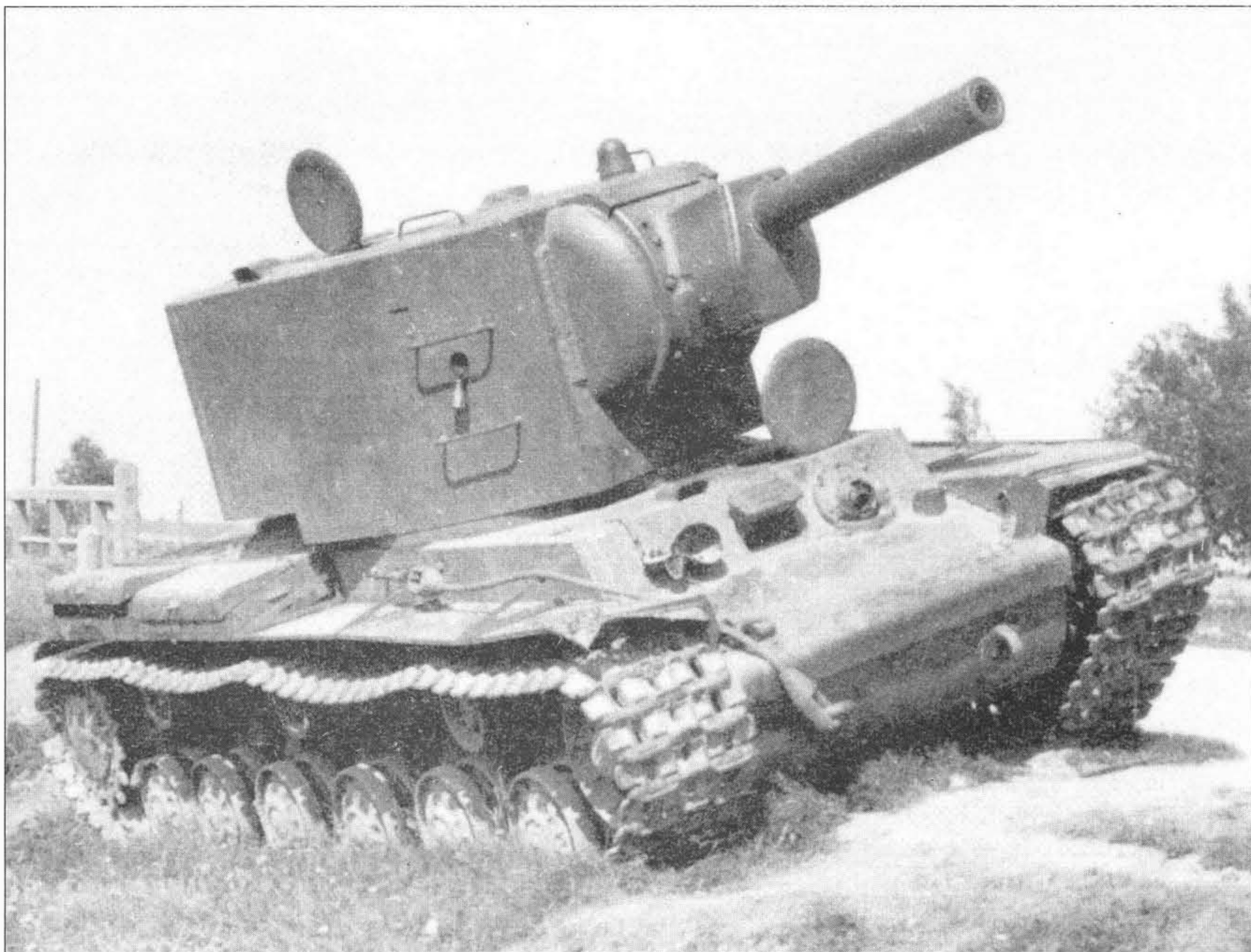
Следующий танк КВ-2 образца 1940 года, подбитый на краю дороги. Обратите внимание на открытую амбразуру для стрельбы из личного оружия экипажа на правом борту башни.
