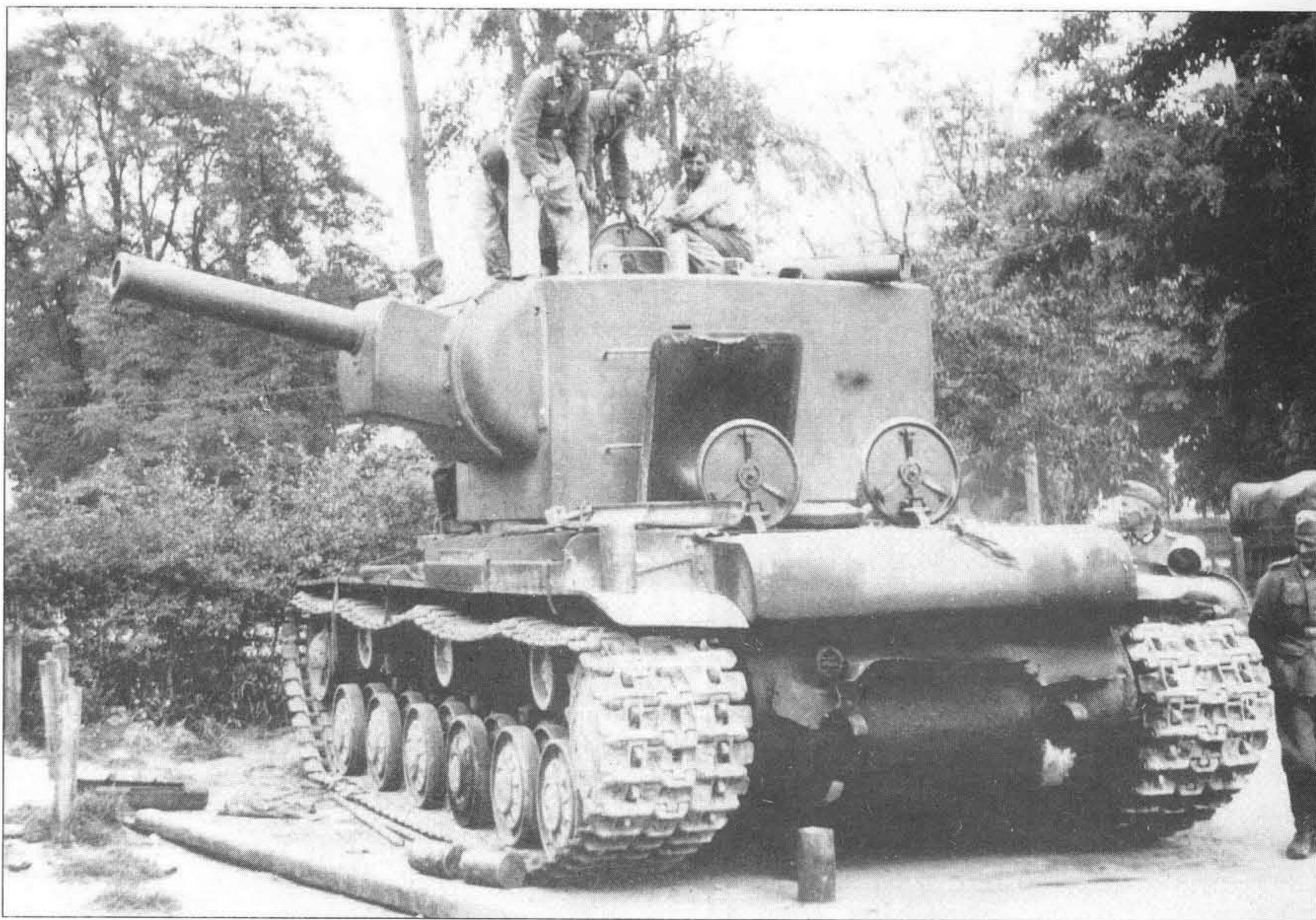
Трофейный КВ-2 подробно осматривается германскими солдатами. На этой фотографии видны внутренние части открытых крышек люков моторно-трансмиссионного отделения.
