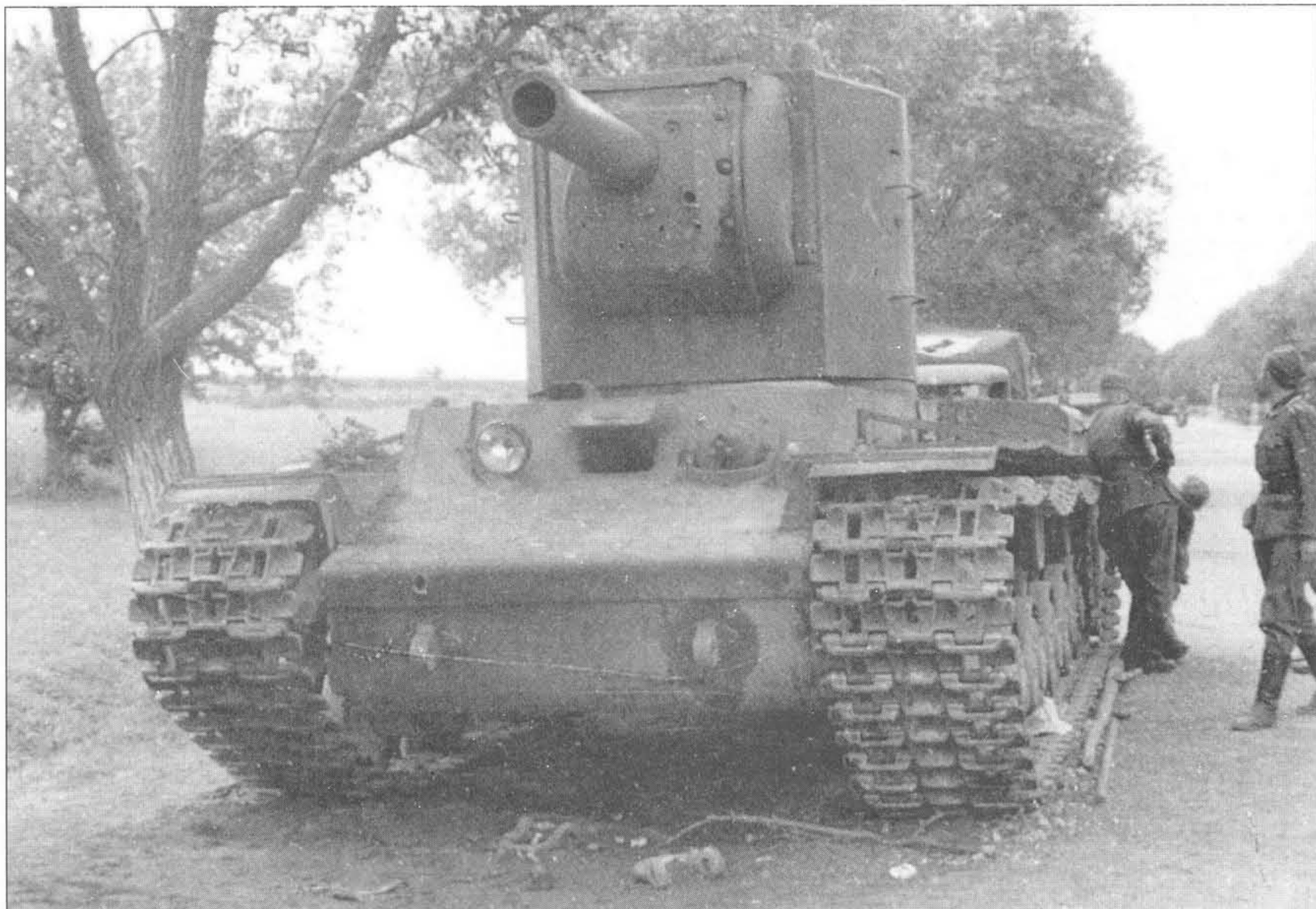
Вид на трофейный КВ-2 спереди, хорошо видны: фара, шаровое крепление курсового пулемета, и открытый смотровой люк-пробка механика-водителя.
