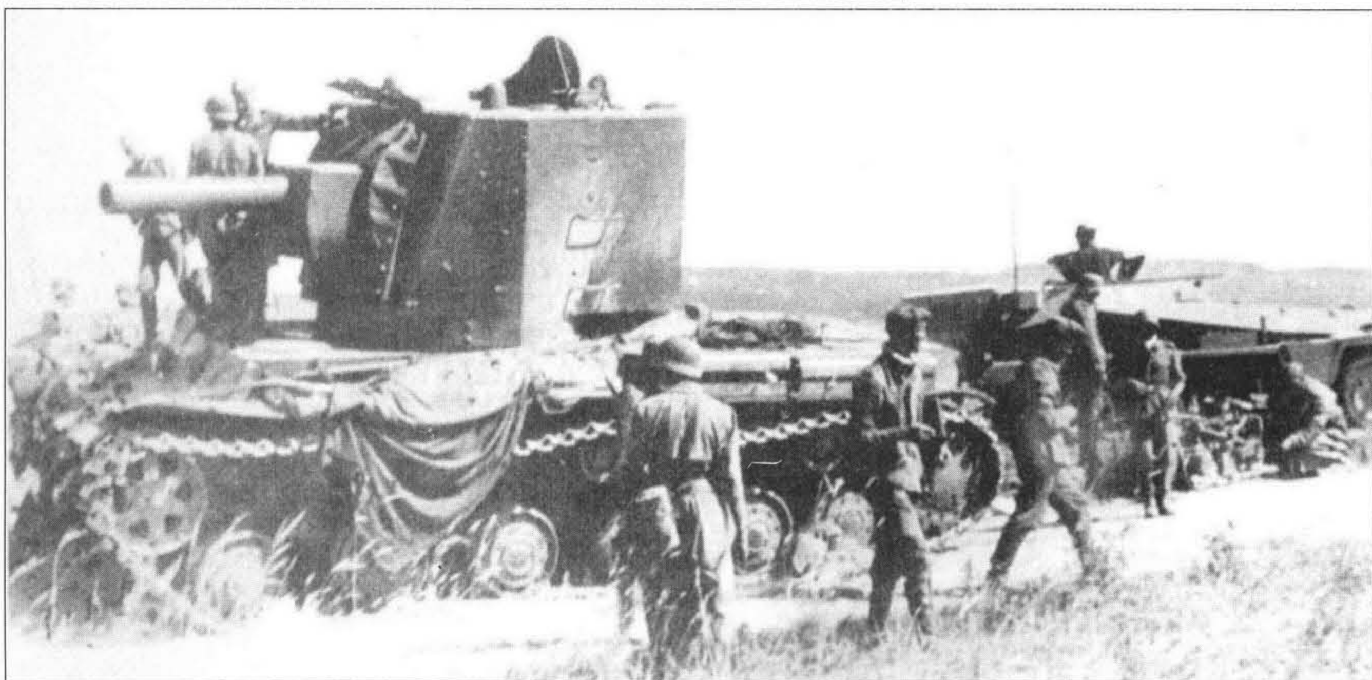
Еще один подбитый KV-2 образца 1939 года, стоящий на обочине дороги. Вероятнее всего это У-1. На заднем плане немецкий бронетранспортер Sd.Kfz. 253. Судя по имеющимся источникам все предсерийные танки KV-2 были потеряны до конца августа 1941 года.
